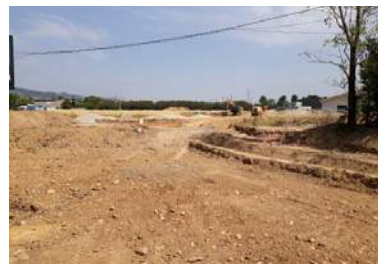
Les travaux du giratoire sont en cours, sur l'emplacement de l'ex Centre d'Insémination Artificielle
