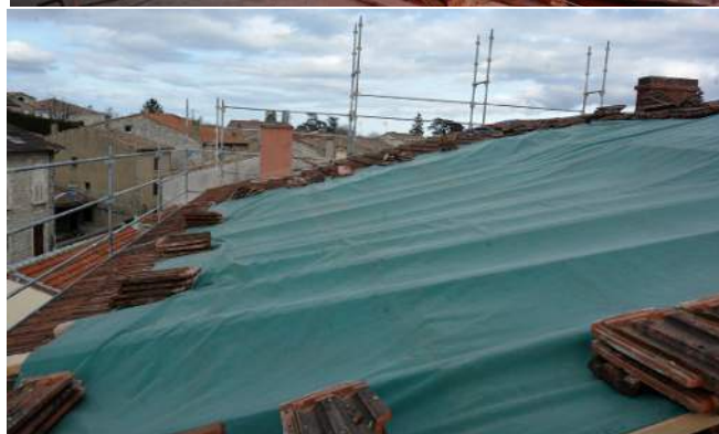
D'importants travaux étaient nécessaires pour remettre le bâtiment en état et aux normes : réfection de la toiture, réalisation d'une dalle, installation d'un ascenseur...
