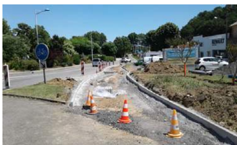
Les travaux sur le giratoire sont en cours
